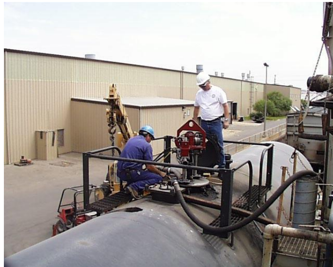
Фото №6. Установка телескопического устройства на горловине цистерны.
