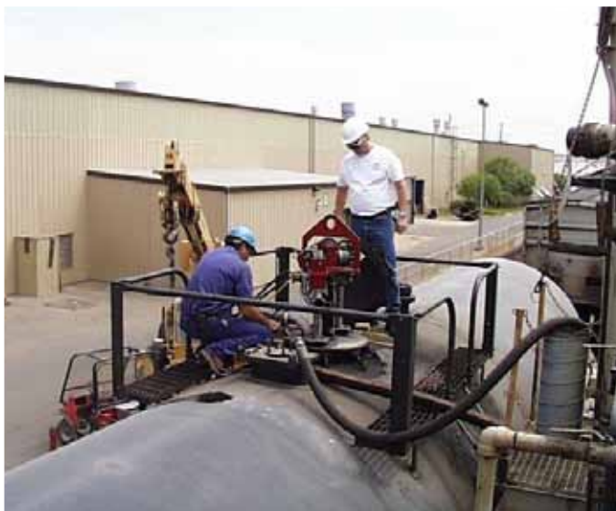
Установка Телескопического Устройства.
