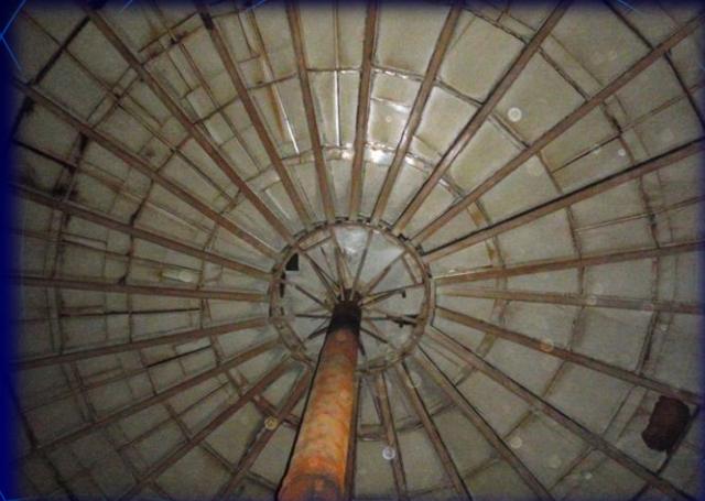
Крыша резервуара после чистки.
